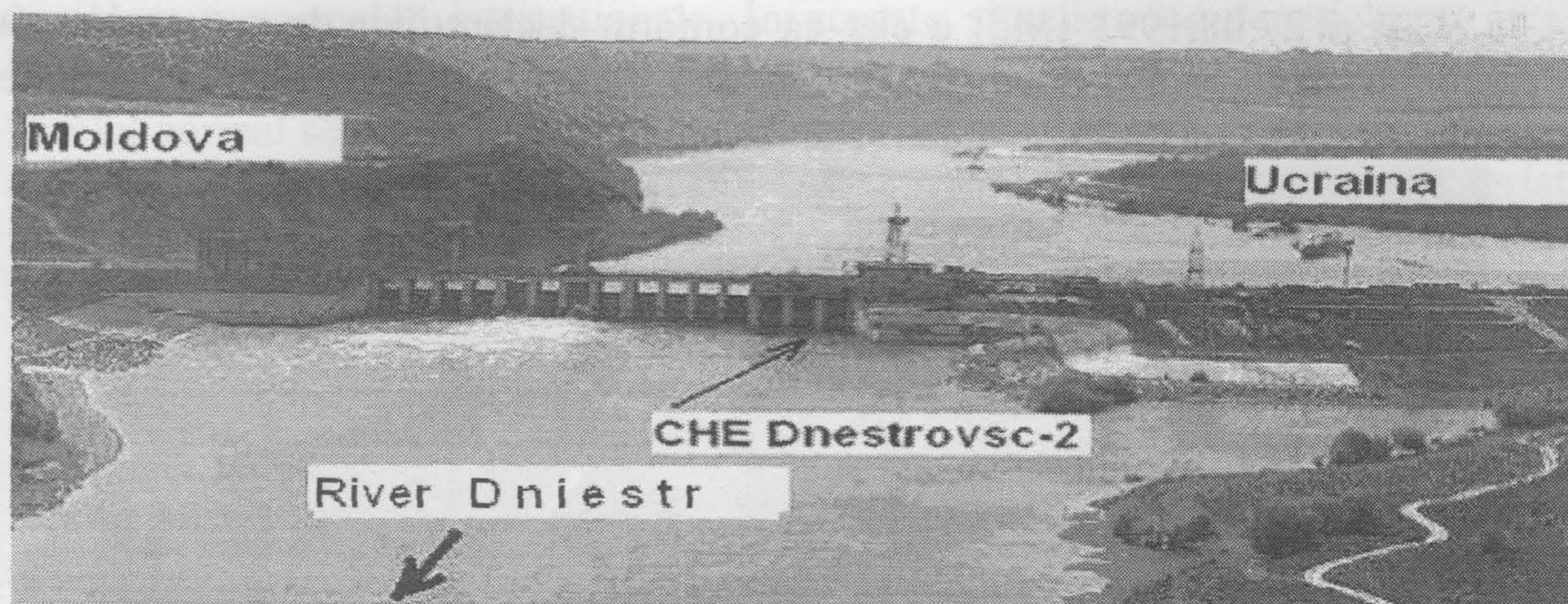
Fig.2. Vedere din aval a barajului Novodnestrovsc 2-Naslavcea cu CHE de 40 MW.
